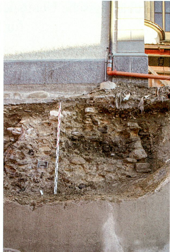
Östliche alte Umfassungsmauer.
