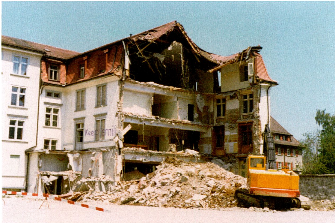
Abbruch des Ostflügels 1981.
