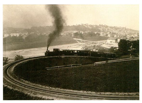
Das «Gääser Bähnli» in der steilen und engen Zahnstangenkurve (92‰, 30m Radius) ob St. Gallen. Postkarte, Poststempel: 21. April 1907.
