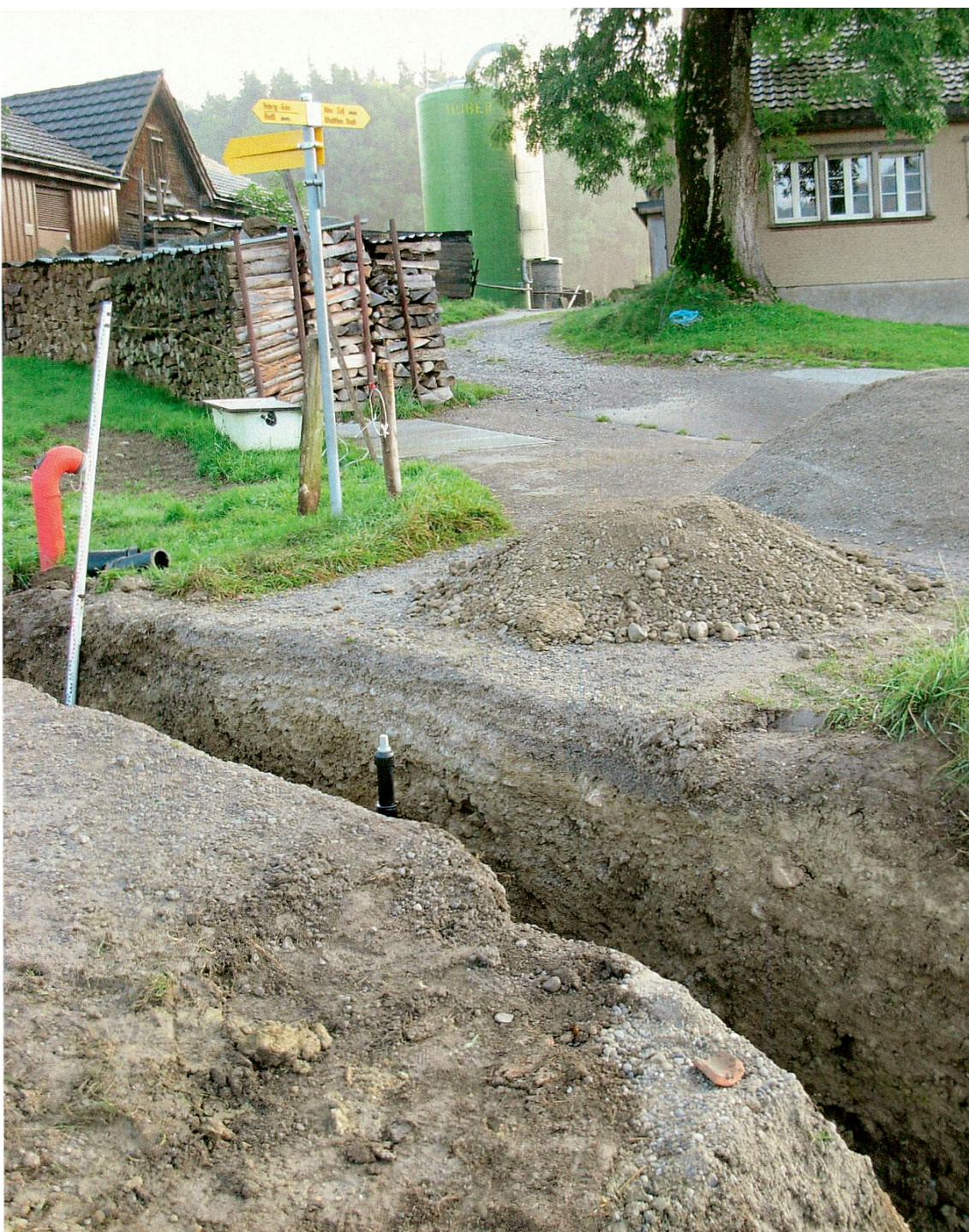
Gais, Stoss: Alte Stossstrasse. Schnitt durch die «Franzosenstrasse». Der Strassenkoffer von 1799-1803 wurde im 19. Jahrhundert mehrfach erneuert.
