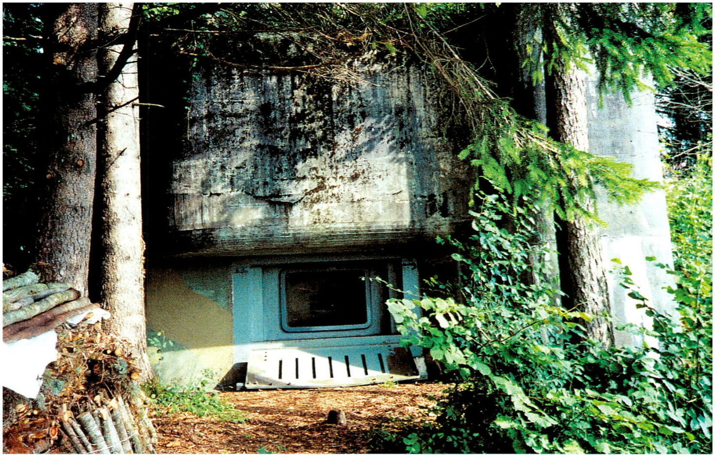
Der gut getarnte, kaum sichtbare Bunker «Stoss-Nord» wirkt mit seinem Maschinengewehr flankierend vor das Panzerhindernis.
