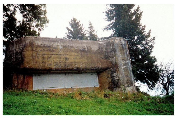
Der Bunker «Stoss-Warmesberg», der umfangreichste in der Sperre, weist eine Betonkubatur von über 1200 m<sup>3</sup> auf.
