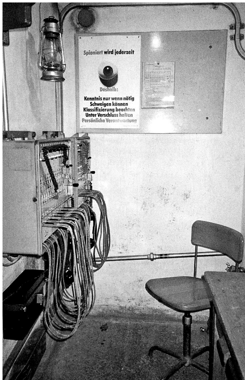
Die Telefonzentrale im Bunker «Stoss-Süd».
