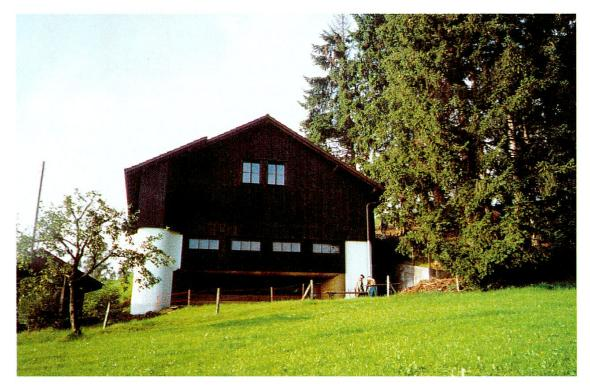
Ein Bunker als Scheune getarnt. Hinter der Fassade verbergen sich über zweieinhalb Meter feste Bunkermauern und Öffnungen für Geschütze.
