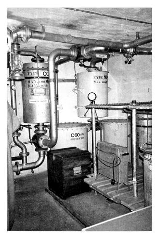
Mit Hilfe dieser Aktivkohlefilter erfolgte im Bunker der kollektive Gas- und Atomstaubschutz.
