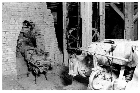
Links hinter dem Mauergewölbe die Maschine zum Herstellen von Backsteinen, davor der Abschneidtisch. In der Mitte der Paternoster-Aufzug, rechts die Maschine zum Herstellen von Drainagerohre (Foto M. Hutter).
