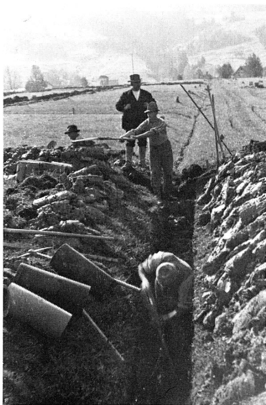
Legen der Entwässerungsröhren
