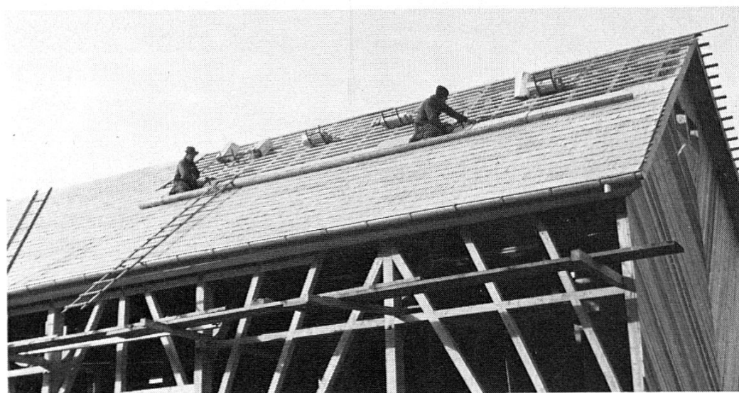
Der Dachdecker legt das Schindeldach
