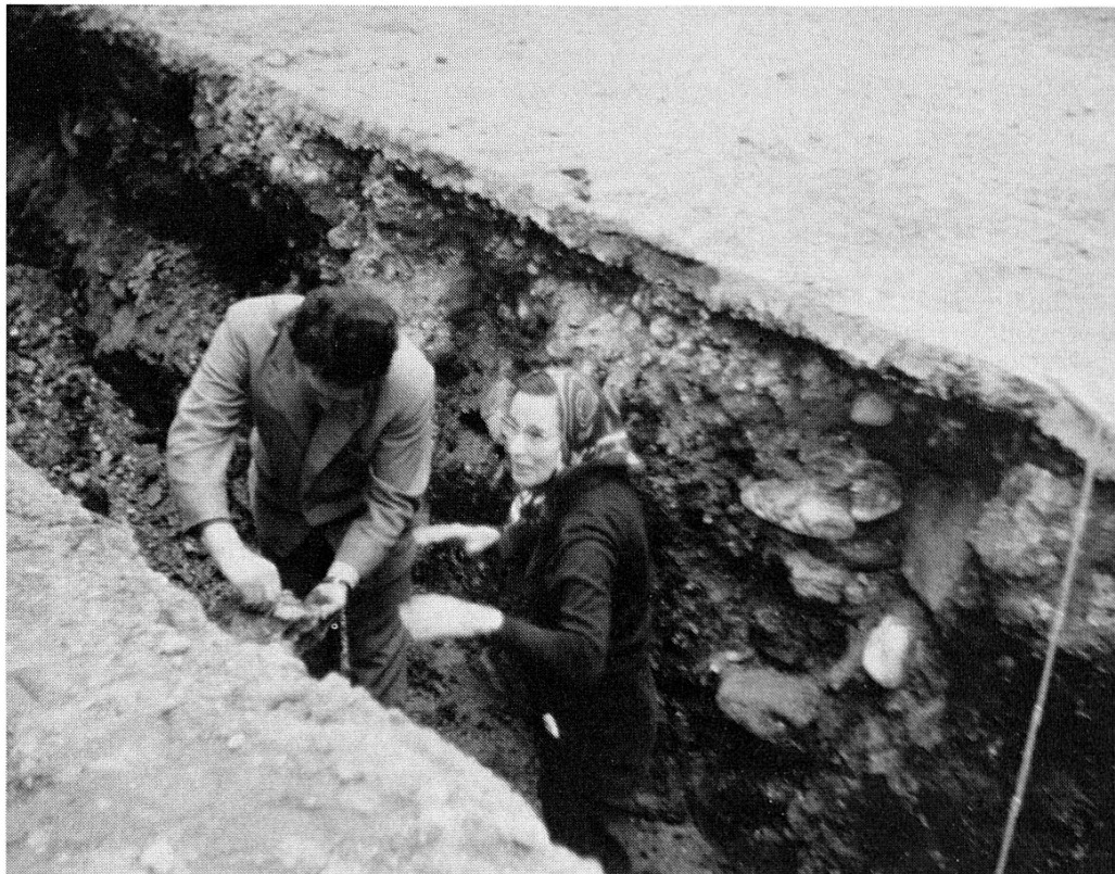
Im Kanalisationsgraben «Schmäuslemarkt» am 15. März 1978 Bauunternehmer A. Koch und Frl. Dr. J. Grüninger
