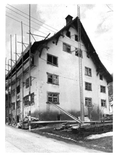
Ansicht der Ostseite des Suworowhauses während der Renovation: Ein Gerüst auf der Strassenseite schützt vor herabfallenden defekten Schieferplatten. Die unüblich (24 Meter!) lange Leiter auf der Giebelseite wurde 1939 speziell für die Renovation des Kirchturms von Elm angefertigt. (Privatbesitz)
