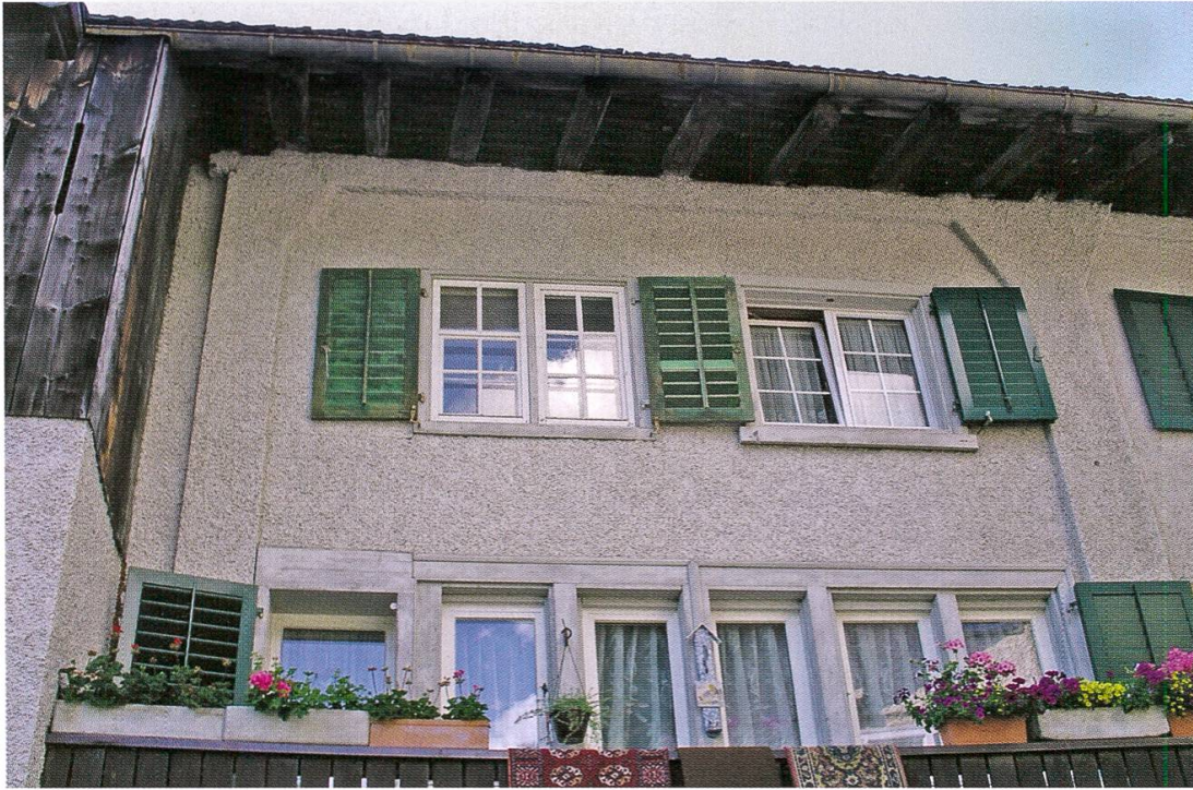
Ständer-Bohlen-Konstruktion des 15./16. Jahrhunderts in Ennetbühls. Das Wandgerüst aus senkrechten Ständern reicht über zwei Geschosse und zeichnet sich in der verputzten Fläche ab. Die dreieckartigen Kopfstreben der Ständer sind sog. angeblattet. Foto Heinrich Speich
