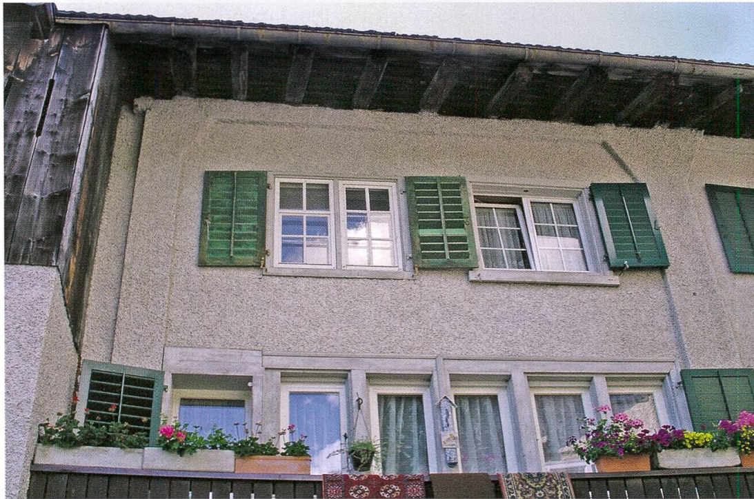
Ständer-Bohlen-Konstruktion des 15./16. Jahrhunderts in Ennetbühl. Das Wandgerüst aus senkrechten Ständern reicht über zwei Geschosse und zeichnet sich in der verputzten Fläche ab. Die dreieckartigen Kopfstreben der Ständer sind sog. angeblattet. Foto Heinrich Speich
