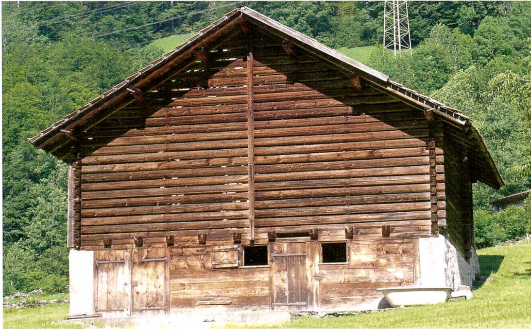
Stallscheune (Gaden) mit maschinell zugerichteten Kanthölzern in Hätzingen, Ende 19./ Beginn 20. Jahrhundert. Typologische Vielfalt, landschaftsprägende Präsenz und sozialhistorische Bedeutung machen Gäden zu wichtigen Inventarobjekten im Sinne der Gesetzgebung. Foto IBID Altbau AG, Heinrich Speich
