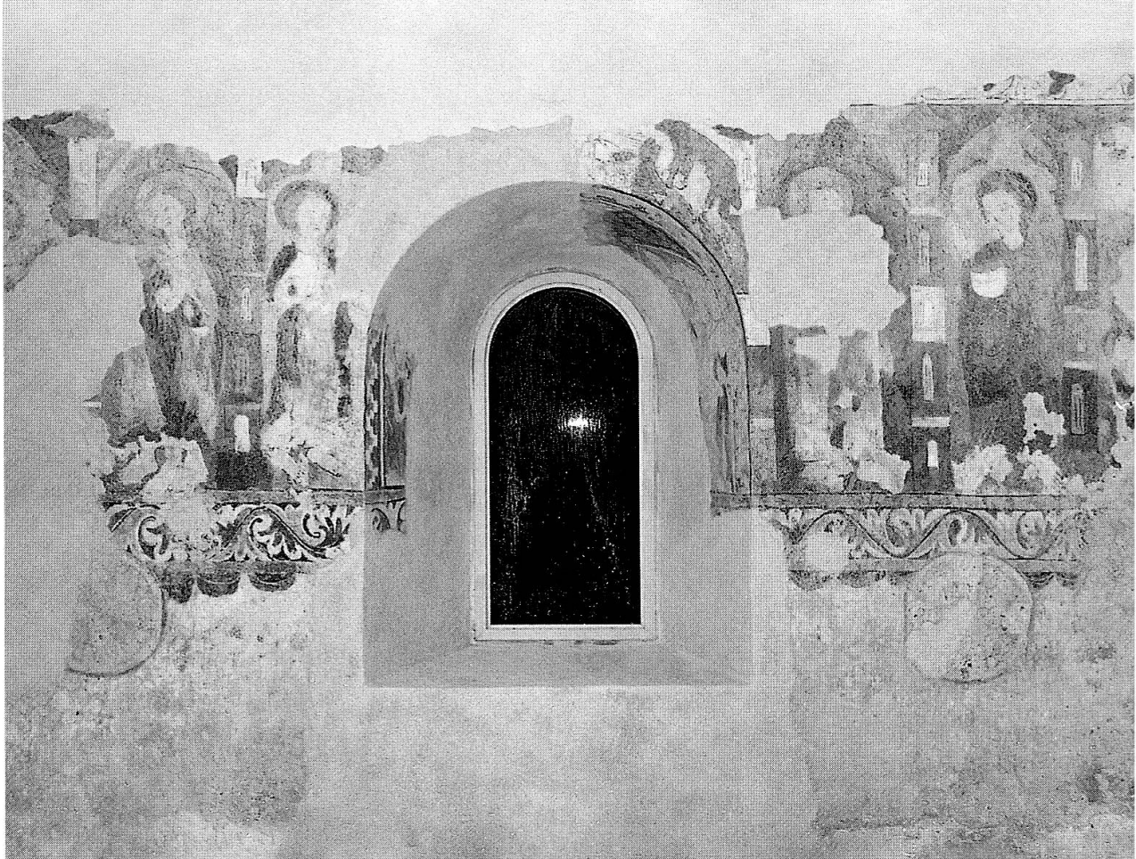
Abb. 5: Apostelfiguren und szenische Fragmente, um 1340/50, Wandmalerei an der Ostwand (E7-E1), Turmchor der reformierten Kirche Obstalden (vor der Restaurierung).
