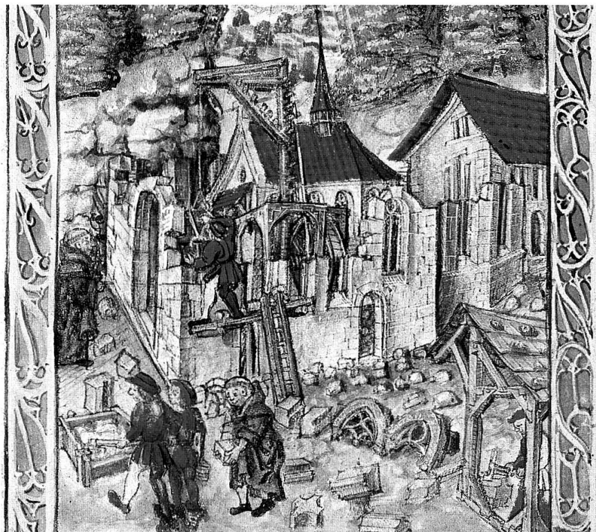
Abb. 3: Die Darstellung vom Bau der ersten Klosterkirche im Hof, Luzern, zeigt exemplarisch, wie der Neubau um den noch aufrecht stehenden Altbau herumgebaut wurde. Illustration aus der Chronik des Luzerners Diebold Schilling, 1513, Fol. 3r. (Korporationsverwaltung der Stadt Luzern)
