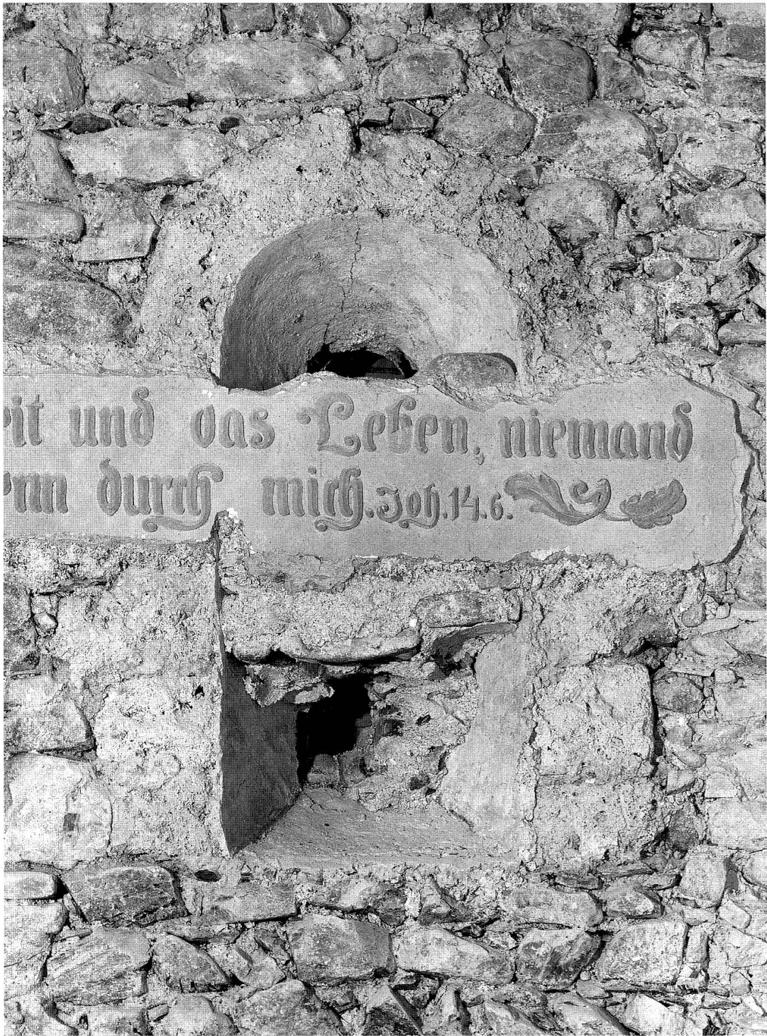
Abb. 6: Das erhaltene Fenster in der Ostmauer.
