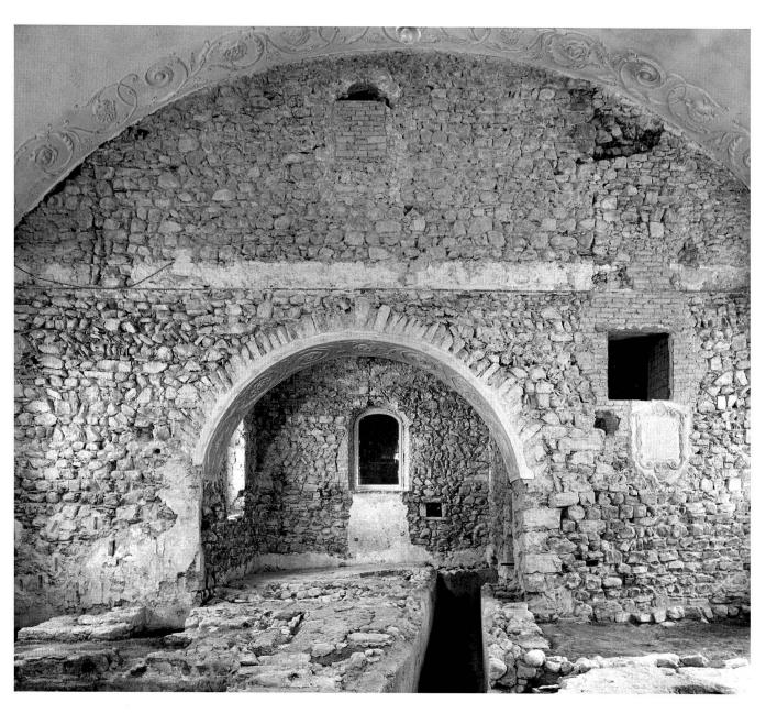
Abb. 3: Die Südmauer des Schiffes mit Chorbogen. An der linken Seite des Bogens ist der Charakter des Mauerwerks der ursprünglichen Kirche deutlich ersichtlich.
