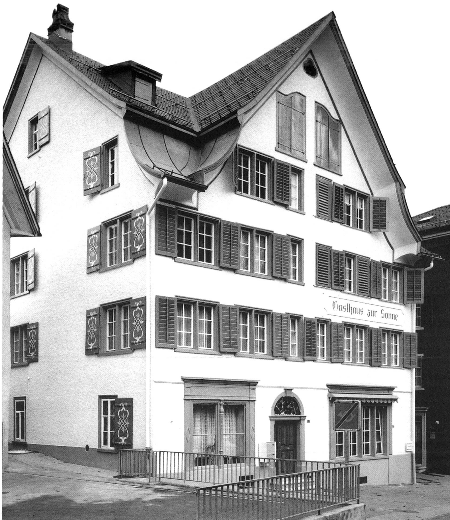
Schwanden; Doppelhaus «zur Sonne» von SW. 1764 erbaut als verputzter Blockbau mit vier Mansardgiebeln, möglicherweise von H.J. Messmer. Erdgeschoss mit nachträglichen Veränderungen.
