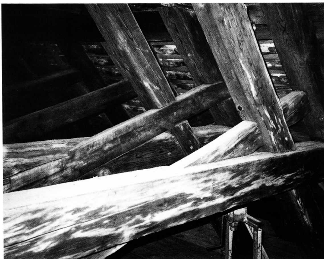
Ennenda; ref. Kirche. Oben: Querschnitt gegen den Chor. – Unten: Einzelheit von H.J. Messmers Dachstuhl (im Querschnitt rechts beim mittleren Kehlbalken).
