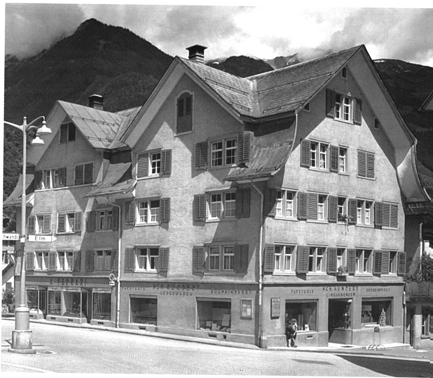
Schwanden; «Sonnenhaus» am Kreuzplatz von SO. Verputzter Blockbau mit Mansardgiebel. Ähnliches Haus angebaut. Bauzeit und Baumeister ungewiss; um 1762/70.
