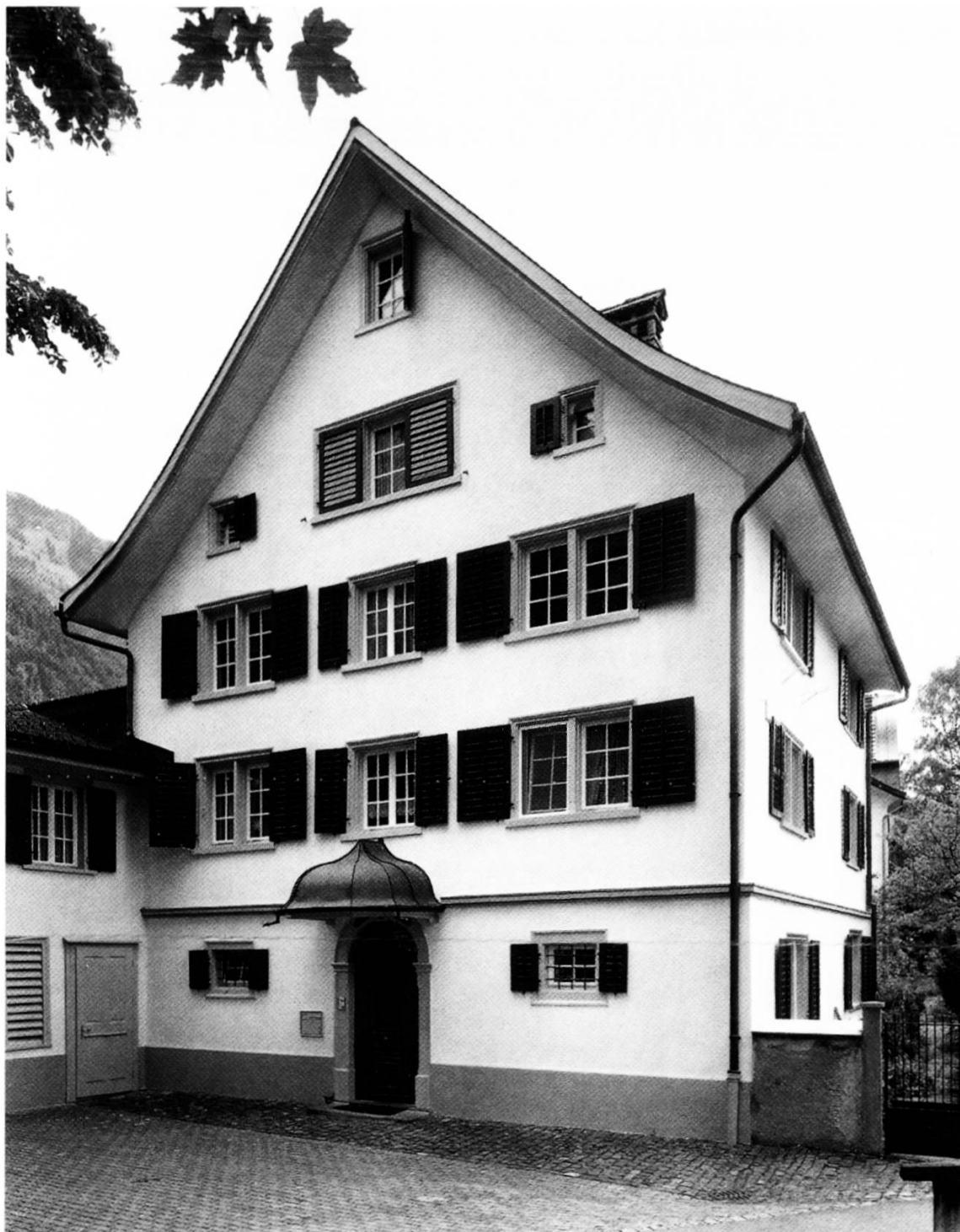
Ennenda; ref. Pfarrhaus von NW. 1775/76 von H.J. Messmer. Ursprünglich ein sichtbarer Holzbau (Strick) auf gemauertem Sockel. Im 19. Jh. Veränderung der Fenster und Vormauerung.
