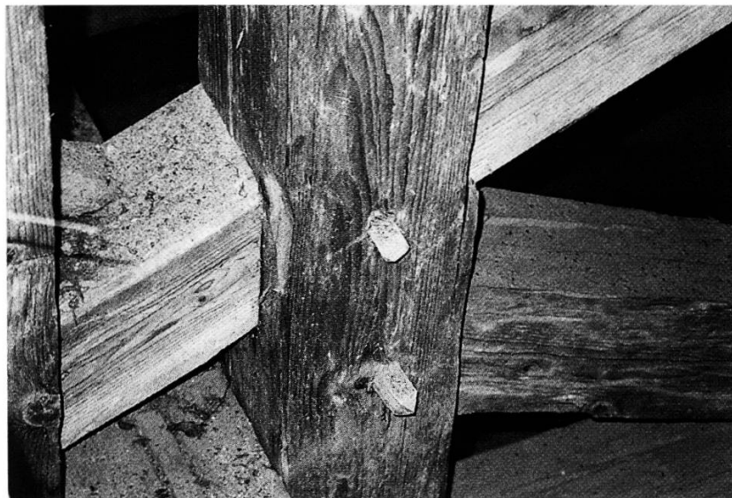
Mühlehorn; ref. Kirche. Einzelheiten von H.J. Messmers Dachstuhl: oben gespreizte Hängesäulen und zweifaches Stabpolygon; unten Holzverbindung einer gespreizten Hängesäule mit dem Streckbalken und Streben.
