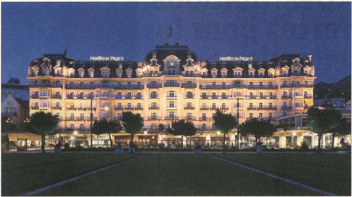
Le Montreux Palace est classé comme bâtiment historique. La direction de l'hôtel doit confronter ses choix avec les exigences des monuments historiques.
