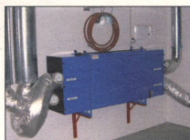
Im Wärmetauscher wird die kalte Zuluft mit der Wärme der Abluft vorgewärmt.
