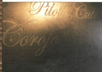
«Pandomo» von Kubny: gestaltungsfähige Masse auf Weisszementbasis, für alle Farbtöne, Stärke 5 bis 6 mm.
