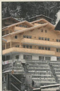
Es wird munter gebaut: Ferienwohnungen in Grindelwald.
