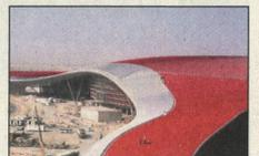
Dass in den Vereinigten Arabischen Emiraten gerne geklotzt wird, ist nichts Neues. Nun kommt ein weiterer gigantischer Bauhinzu: Mit einer Fläche von mehr als 50 Fussballfeldern besitzt «Ferrari World Abu Dhabi» eines der grössten Dächer der Welt. Das Metalldach – eine Stehfalz-Konstruktion der Firma Interfalg – der Freizeitanlage, in der sich alles um PS und Boliden dreht, ist über 21000 Quadratmeter gross, wiegt über 900 Tonnen und brauchte über 100000 Liter Ferrarierote natürlich. fee
