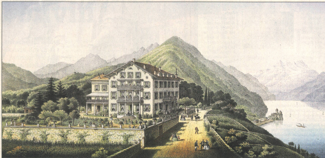
Construit en 1829, l'Hôtel Pension Masson est un témoin du tourisme des premières heures.
