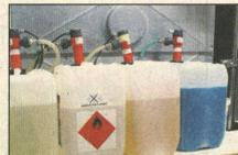
Waschmittel wird den Waschmaschinen automatisch zugeführt.
