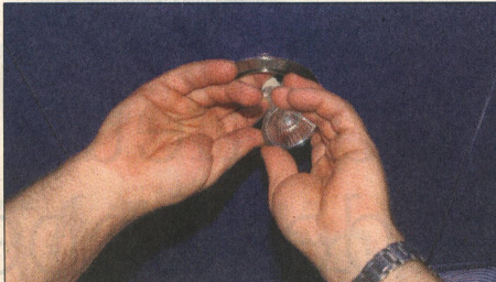
Die Halogenlampe wird in die Garderobenabdeckung montiert.
