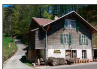
Im Berner Oberland führt der Weg am Brüning Zollhaus vorbei.
