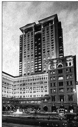
■ Das Peninsula Hong Kong Hotel verfügt über ein System, das in einer Schleuse automatisch das Fieber misst. Foto: zvg
