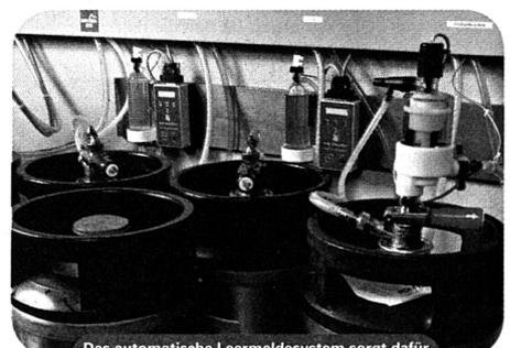
Das automatische Leermeldesystem sorgt dafür, dass kein Schaum in die Bierleitung kommt.
