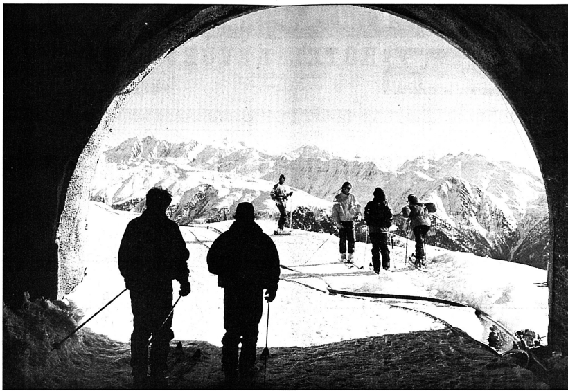
Der neu erstellte Skitunnel am Bettmerhorn hat ein weiteres Skigebiet erschlossen.
