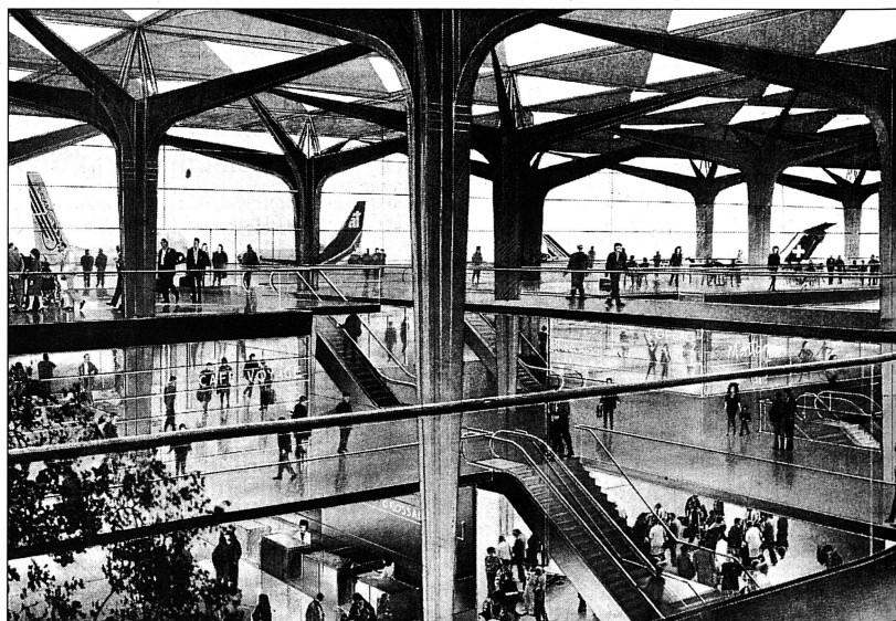
Die Innenansicht des neuen Passagierterminals.
