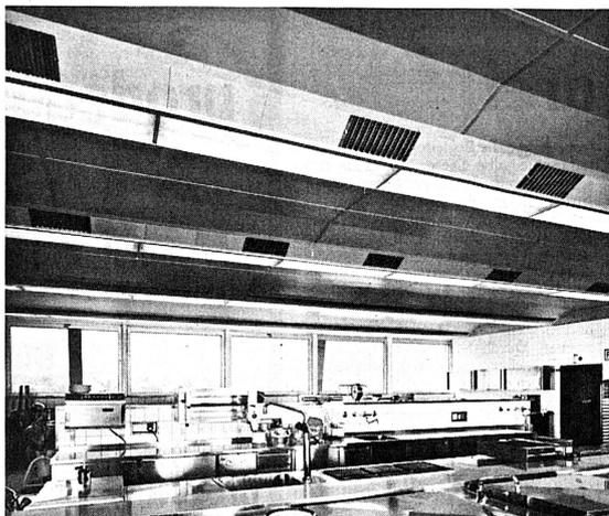
Der Trend in den Grossküchen geht mehr und mehr zur Zentralisierung der Küchengeräte. Das erfordert, die nach den Arbeitsabläufen zusammengestellten Koch- und Bratbereiche mit einer grossen Dunsthaube zu überbauen. Durch umlaufende Absaugkanäle können starke Dampfentwicklungen wirkungsvoll abgesaugt werden.
