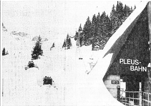
416 Meter Höhendifferenz, 1556 Meter schräge Länge und eine Stundenkapazität von 1100 Personen: Dies die wichtigsten Daten der neuen Sesselbahn Pleus. Alle elektrischen Versorgungsleitungen wurden in den Boden verlegt.
