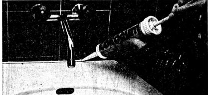
Schadhafte Fugen zwischen Plättli und Bodenfliesen oder eingebrochene Fugen bei Badewannen und Lavabos hinterlassen einen schlechten Eindruck. Diese Bagatell-Schäden lassen sich leicht selbst reparieren!
