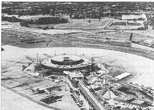
Le terrain sur lequel la nouvelle aérogare sera construite au nord-ouest du satellite. Au premier plan, le monorail assurant le transbordement des passagers.
