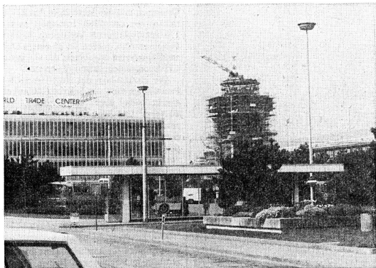
La tour de contrôle de Genève-Cointrin en construction.
