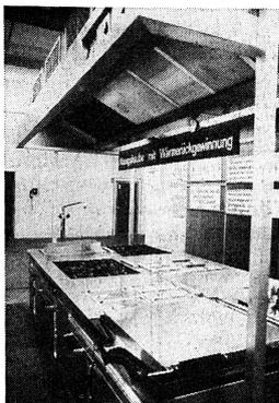
Bis zu 80 Prozent Energie spart diese Edelstahl-Dunstabzugshaube mit Wärmerückgewinnung ein. (Schmalhofer KG, Hildebrand AG, Aadorf)
