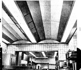
Einbaufreundliche, massgeschneiderte MS-Lüftungsdecken aus Chromstahl oder eloxiertem Aluminium mit integrierter Beleuchtung, leistungsstarker Abzugventilation und den neuartigen Fettscheidern bilden heute die unübertroffene Ideallösung für alte und neue Profiküchen.
