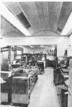
Der Kern des Umbaus, die neue Küche, ist zwar keineswegs überdimensioniert, dafür aber sehr zweckmäßig. Die Lüftungsdecke (Wimwick) lässt sie sogar relativ geräumig erscheinen.
