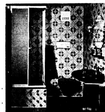
Nasszelle mit Dusche, Lavabo und WC
