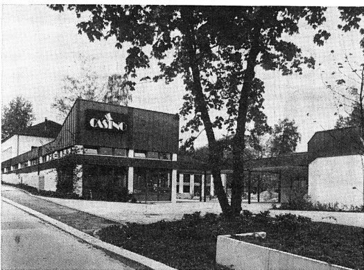
Als erste Stadt der Nordwestschweiz verfügt Rheinfelden seit Ende Mai über ein Casino. Fast nahtlos geht der alte, renovierte Trakt (links mit dem Verkehrs- und Reisebüro im Vordergrund) in das neu erstellte Restaurant (rechts) über.
