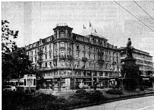
«Tor zur Bahnhofstrasse» in neuem Glanz: Allein für die Renovation der Fassade und der Dachaufbauten wurden 1,5 Millionen Franken aufgewendet.
