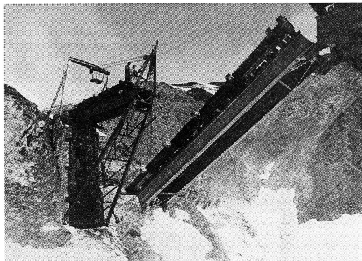
Brücke mit Scharnieren: Alle Jahre wieder baut die Furka-Oberalp-Bahn nach siebenmonatiger Winterpause die Fahrleitungen und die klappbare Bahnbrücke über das Steffenbachobel wieder auf. In absehbarer Zeit wird man sich die Demontage- und Aufbaukosten von über 100 000 Franken pro Jahr sparen können: Mit der Inbetriebnahme des Furka-Basistunnels wird der Betrieb auf der Bergstrecke eingestellt. (Comet)
