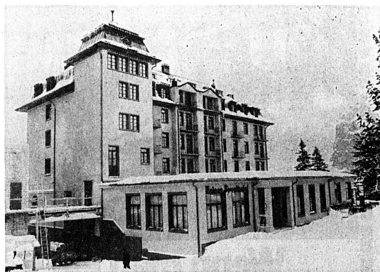
Aufgefrischter Veteran: Das Mürren Palace in neuem Gewand. Links im Bild die neue Energiezentrale
