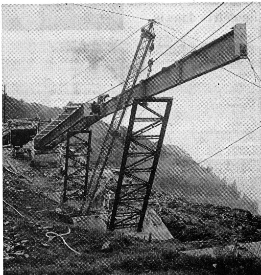
Am 2. Februar 1978 riss eine Lawine den unteren Teil der Hegerbrücke der Niesenbahn auf einer Länge von 60 Metern weg. Mit einem Aufwand von 600 000 Franken wurde in einer ersten Phase der Viadukt mit einer Stahlkonstruktion wieder befahrbar gemacht. Weitere 1,2 Millionen werden nötig sein, um die Brücke und den Hang der Hegeralp lawinsicher zu gestalten. Ende Juli fährt die Niesenbahn wieder. (Bild: Burlon)
