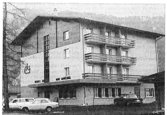
Hotel Krone im Kienholz bei Brienz: 27 Doppelzimmer mit Balkon.
