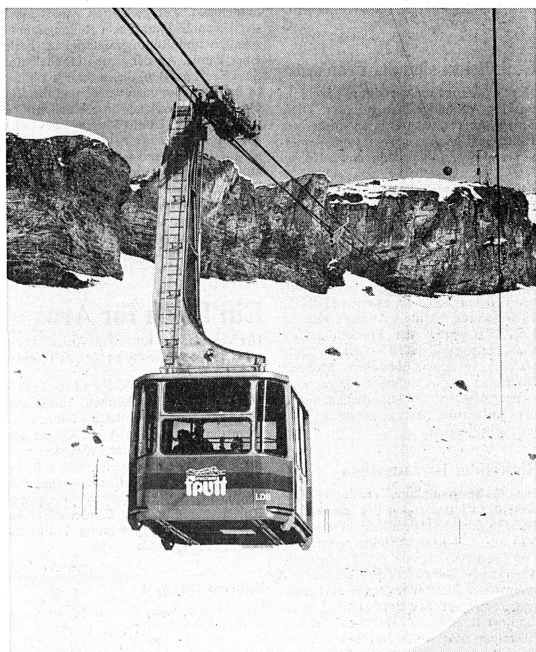
Die neue Luftseilbahn von der Frutt auf den Bonistock. Sie kann durch eine zweite Kabine auf doppelte Kapazität erweitert werden. (Bild Kehrer)
