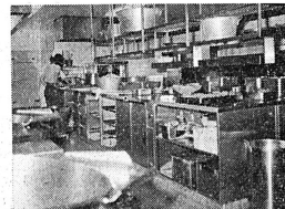
5 Die Produktionsküche des Hotels International Basel, in einer anderen Etage als die Ausgaben gelegen. Hier die Warme Produktion mit grossem Mittel-Arbeitsstisch und den Kochgeräten aussen herum. Direkt dabei liegen Rüsterei, Gardemanger, Kalte Produktion, Patisserie, Plonge und diverse Kühlräume, daneben die Fertigungsküchen für die Restaurants, die Bankettküche, der Swimming-Pool-Snack und die Personalkantine beliefert.
