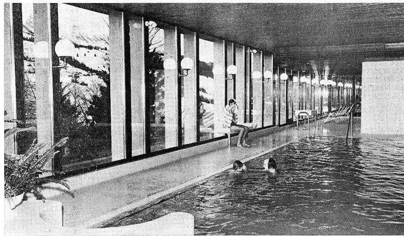
Hotel Acker Wildhaus jetzt mit Hallenbad: Nach achtmonatiger Bauzeit konnte am 12. Dezember die neue Anlage feierlich eingeweiht und in Betrieb genommen werden. Die vollklimatisierte Halle umfasst ein ozonbereitetes Schwimmbassin (6,5 x 15 m) mit rund 120 m 3 Wasser (Temperatur 28-30 Grad), Sauna, Fitness-Center, Liegehalle, Liegewiesen und eine Aussichtsterrasse. Die Schwimmhalle ist durch einen unterirdischen Gang mit dem Hotel verbunden.
