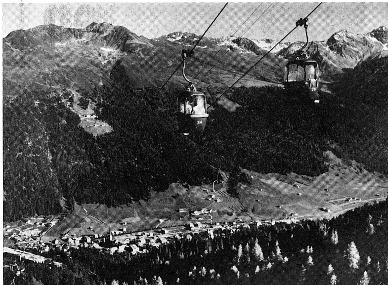
Gondelbahn Schatzalp-Strela mit Blick nach Davos und Brämbühl-Jakobshorn.
