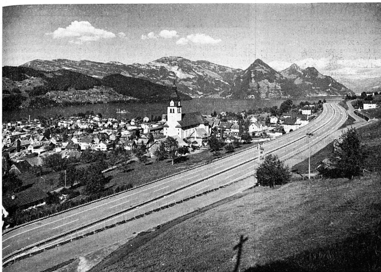
Cette photo de Buochs (NW) résume bien la Suisse centrale: un site enchanteur au carrefour de deux époques qui n'ont pas trop de problèmes de coexistence. Sans oublier ces routes qui, dans un sens ou dans l'autre, montrent une fois le chemin de la Romandie...
