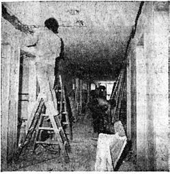
Leerrohrleitungen und Einbaudosen für künftige Bedürfnisse wurden gleich mit eingelegt (Feuermeldeanlagen, Telefon). Beleuchtungskörper neu, auch in Korridor, WC und Duschraum. Ueberall Tonbeleuchtung (wobei die Anschlüsse zum Teil schon von früher vorhanden waren). Leider musste die Verteil- und Sicherungsanlage komplett neu installiert werden, was immerhin zirka 20% der Elektrokosten ausmachte.
