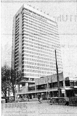
10 Auch beim Hotel International in Oerlikon klare Trennung der Betriebsbereiche: Der Zimmerblock als dreistöckige Anlage sozusagen ein selbständiger Baukörper, der Sockel zweigeschossig mit 4 Untergeschossen. Die Fassade kann auf den Verwendungszweck der einzelnen Raumgruppen ausgerichtet werden.
