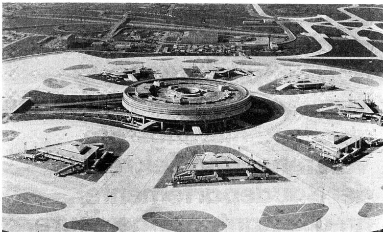
Vue d'ensemble de l'Aéroport Charles de Gaulle, à Roissy-en-France; le corps central est entouré de ses sept satellites. On distingue à gauche les rampes d'accès et de sortie pour les voitures stationnant sur la plate-forme et, devant les satellites, les passerelles télescopiques pour embarquer et débarquer les voyageurs.
