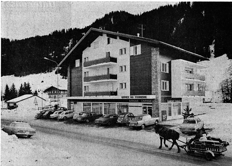
Le nouvel immeuble de l'Office du tourisme de Morgins, carte de visite d'un vaste circuit touristique international.
